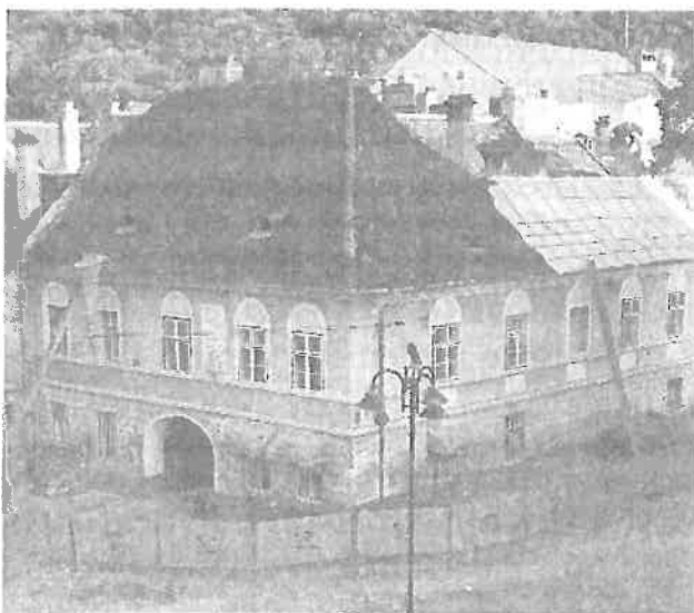
Der Anfang der Bauarbeiten.
