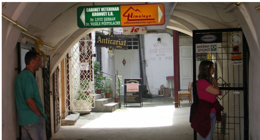
Blick in den Hof vor Baubeginn, links die tierärztliche Praxis, rechts das Sportartikelgeschäft und hinten links das Antiquariat.
